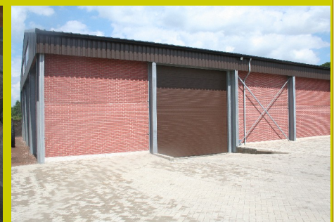
De vloer van de nieuwe loods ligt 80cm lager dan het maaiveld.
